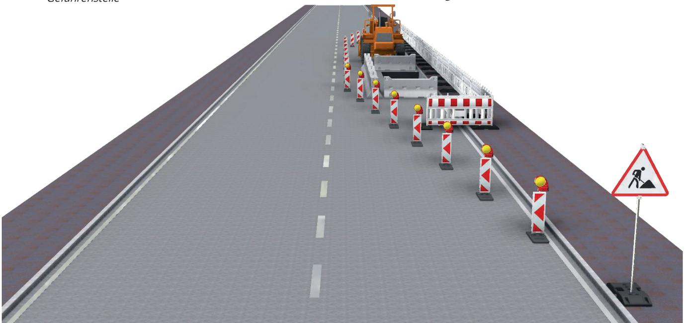
Abb. 4: Betonelemente in einer Tiefbaustelle mit Straßenspernung als Absturzsicherung und Anfahrtschutz mit Schranken-
